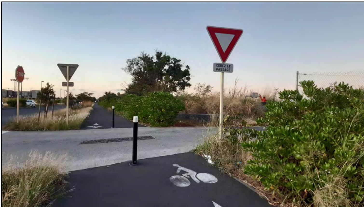
Intersection existante (mai 2022) entre le chemin Grands Fonds et les pistes piétonne et cyclable. La signalisation donne la priorité aux véhicules empruntant le chemin Grands Fonds.
